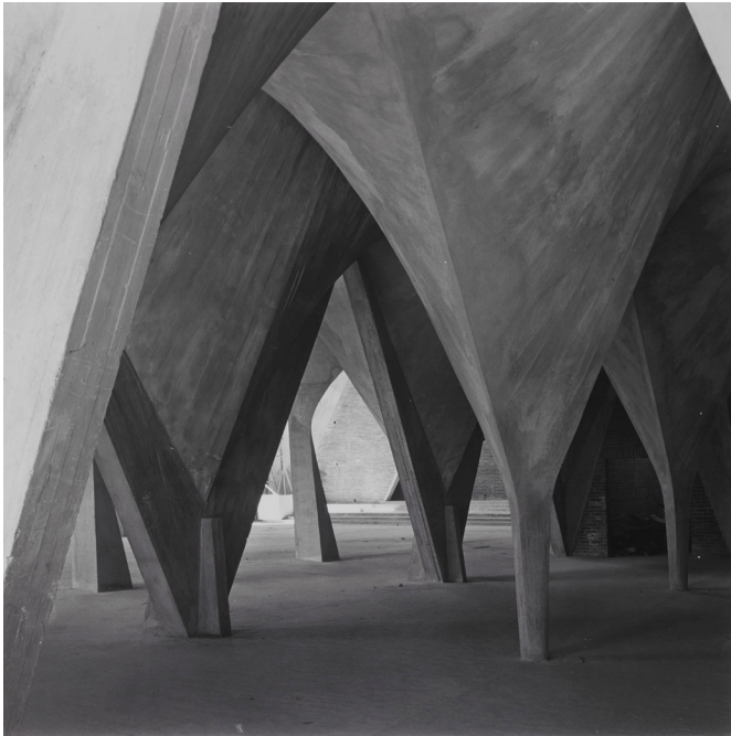
◀ Iglesia de la Virgen Milagrosa. Navarte. México D.F. Vista interior durante la construcción. Fot.: Erwing Lang. The Rosalie Thorne McKenna Foundation.
