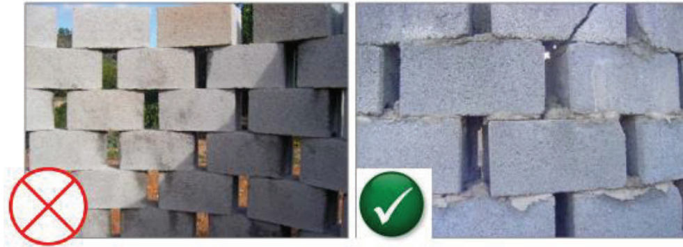
Imagen 4. Construcción formada por bloques con y sin cemento. Fuente: Norma Técnica de Quemadores Agrícolas. Plan de Prevención de Incendios Forestales de la Demarcación de Crevillent.
