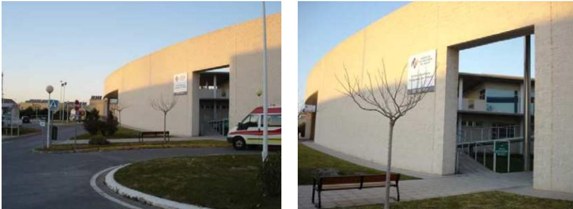
Como se observa en las fotografías anteriores, el diseño de dicho Centro Sanitario, cuenta con un muro en forma de falsa fachada que permite reducir el impacto acústico en el ambiente exterior generado por el vial situado a 50 m. del mismo, que acompañado con elementos constructivos adecuados de las fachadas interiores permiten la no transmisión de niveles sonoros superiores a los máximos permitidos en el interior de las dependencias.
