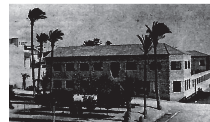
Edificio de la calle Valencia en construcción. Revista Crevillente-Semana Santa 1956.
