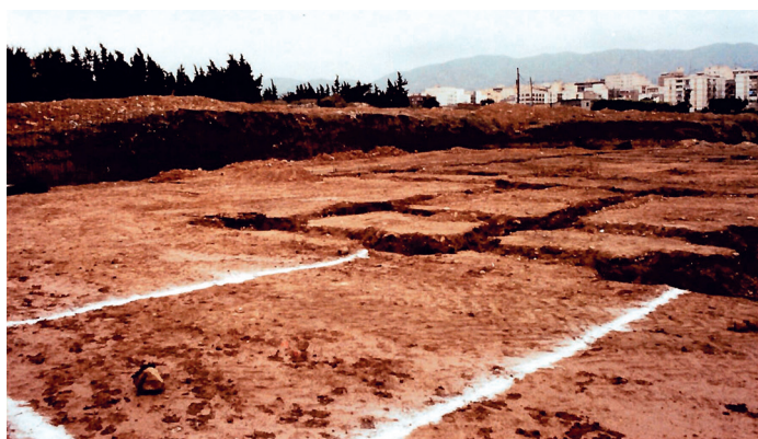
AMCR, Fotografías preliminar obras de construcción del Instituto de Formación Profesional en Partida Arquet, 28-2-1992, Sig. 8127/1.
