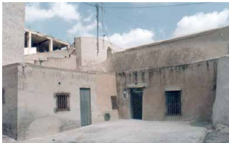
Imagen 11: Vista de una construcción anexa a la vivienda-cueva con acceso desde el exterior situada en la calle Vereda Hospital.
