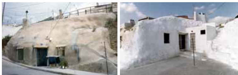
Imagen 08 y 09. Fotografías de viviendas-cueva donde se ha revestido directamente sobre el terreno. Actual Calle Vaiona 24 y Calle Violín Viejo nº 1. Fuente: extraído de “Las Cuevas de Crevillent, Estudio y catálogo gráfico”. (García Aznar y López Davó 2000)
