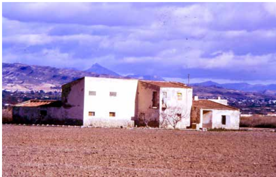
Fig. 34. El Realengo, vivienda en el campo.
