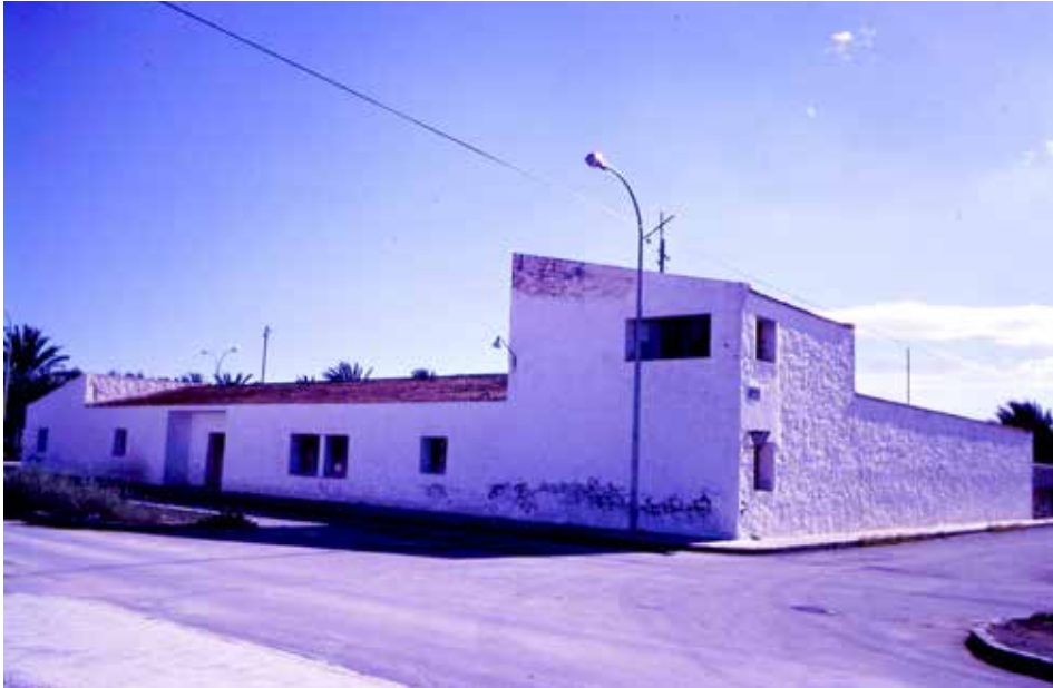
Fig. 23. El Realengo, edificio de la antigua Cooperativa Agrícola.
