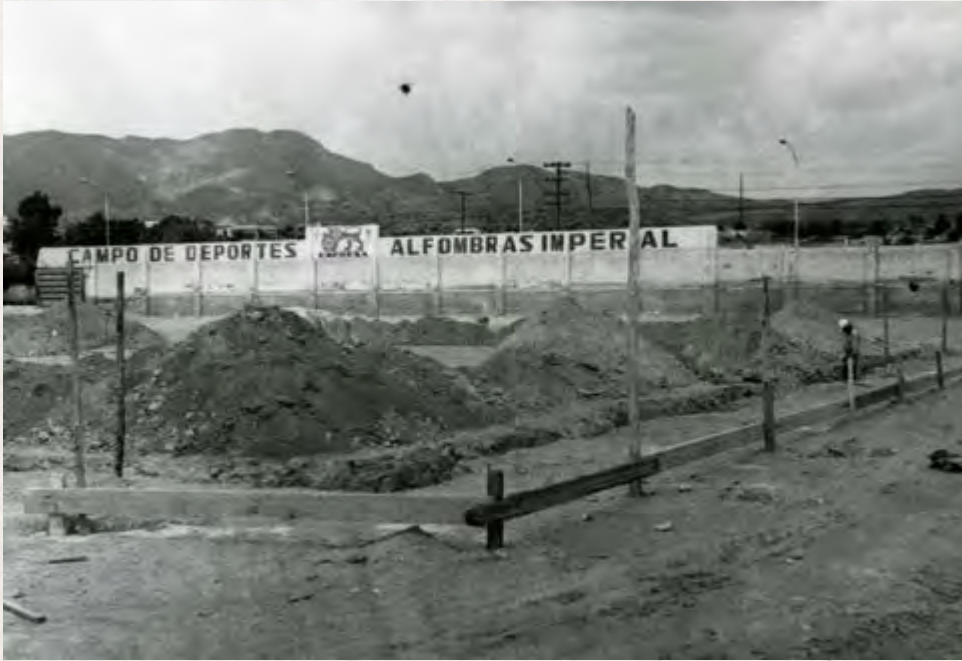
Fig.25. Excavación para la cimentación de la nave junto a la carretera N-340, año 1965
