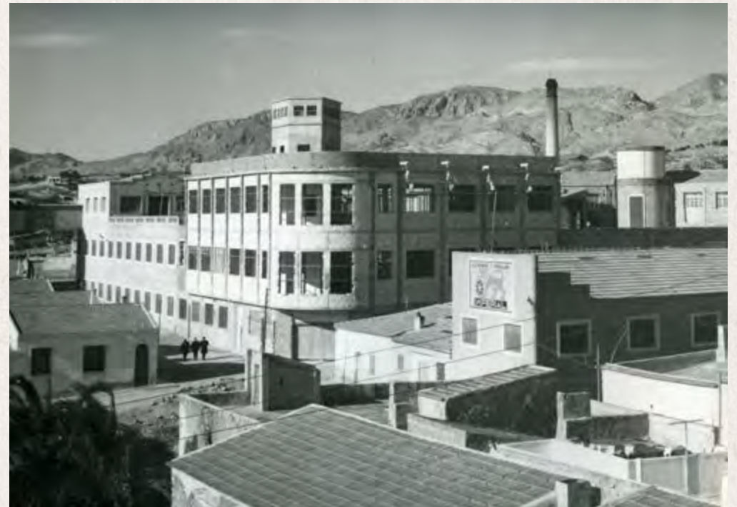
Fig.18. Vista general del complejo fabril de Alfombras Imperial en construcción, años 1960-1962
