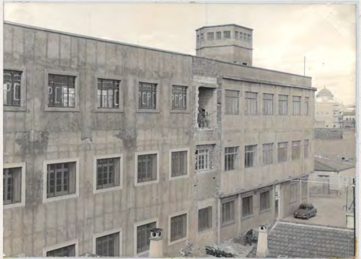
Fig.14. Construcción de oficinas y departamentos técnicos, 1964
