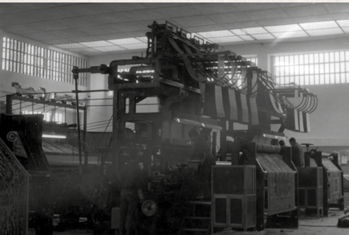
Fig.52. Telar automático doble tela Van de Wiele (origen Bélgica), año 1965
