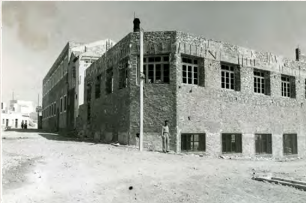
Fig.11. Construcción nave en calles Cisneros y Rvdo. Pascual Martínez, año 1955
