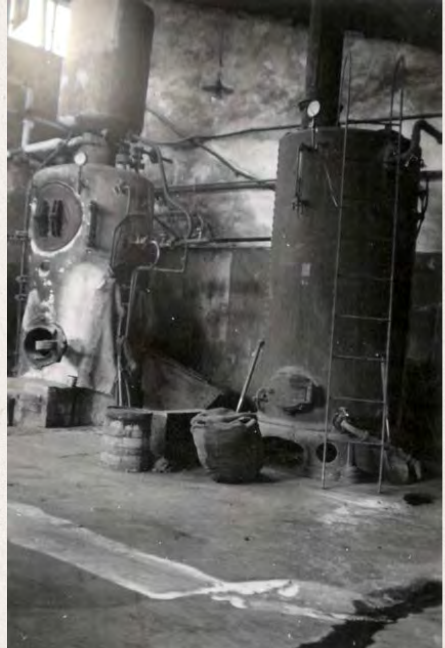
Fig.50. Primeros generadores de vapor situados en la tintorería (1932-1945)
