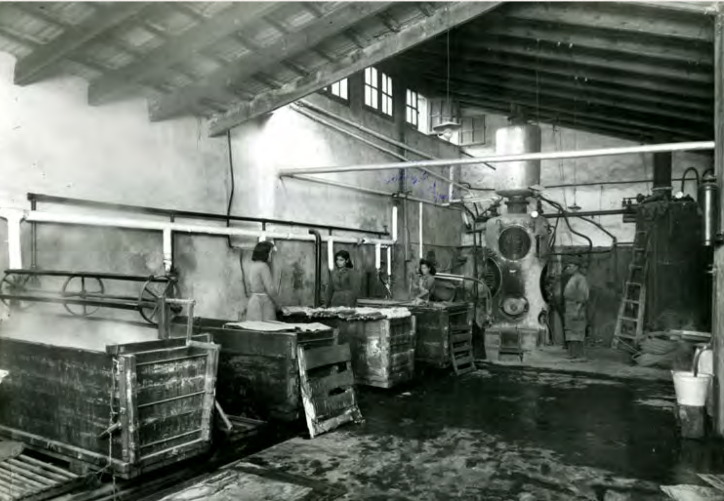
Fig.46. Sección de tintorería, primeros generadores de vapor (1932-1945)
