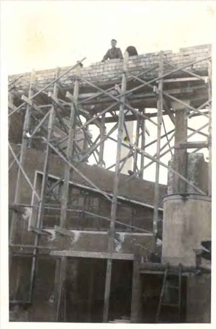
Fig.13. Construcción del puente que unía el antiguo secadero con tejado de carrillera y pasarela de hormigón armado, año 1951. Dicha pasarela fue sustituida por una más corta con la ampliación de la tintorería.
