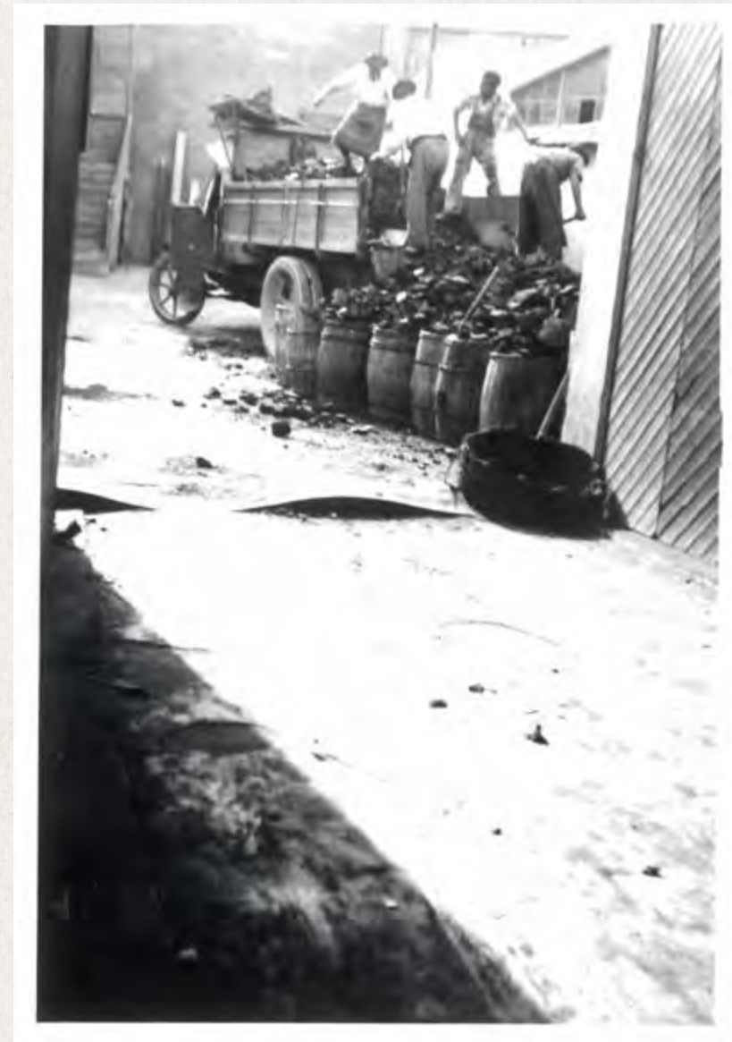
Fig.12. Antigua acceso a fábrica, calle Cervantes nº 4, hacia el interior del patio. Descarga del carbón para las calderas.
