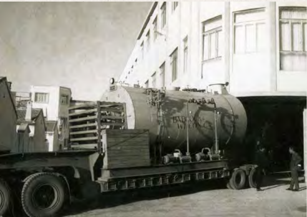
Fig.20. Descarga de nueva caldera de vapor procedente de Bilbao, año 1967
