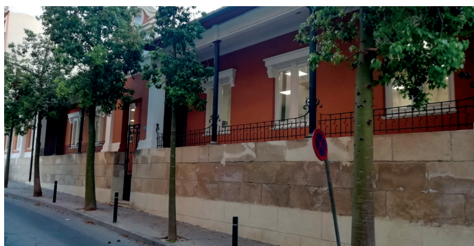
Antiguas escuelas Primo de Rivera (1928), hoy oficinas municipales.
