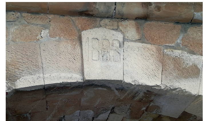
Detalle del año de construcción del puente Jorge Juan.
