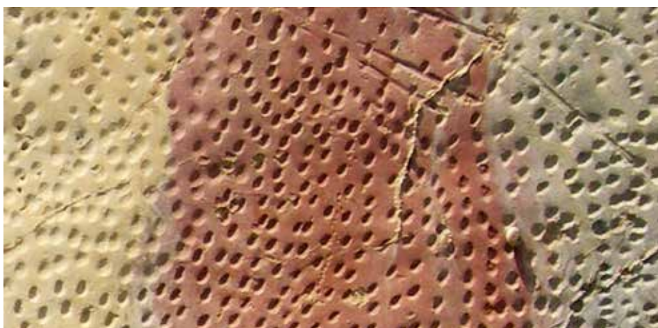
zh. Obra de la séquia de l'aigua del Poble.
