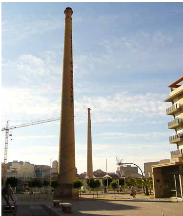
Figura 9. Chimenea Fábrica de Conservas La Molinera (Molina de Segura)
