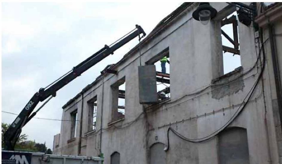
Fig.7 Trabajos de demolición de la antigua fábrica textil en la calle Orberá de Alcoy tras un incendio en 2011. Fuente: Diario Información Alicante 16/XI/2011.
