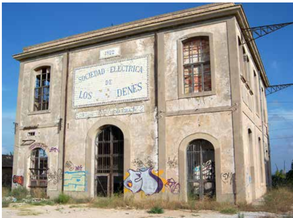
Estació transformadora de la Sociedad Eléctrica de Los Almadenes , en 2009, abans de tapiar portes i finestres. Manuel Carreres Rodríguez.
