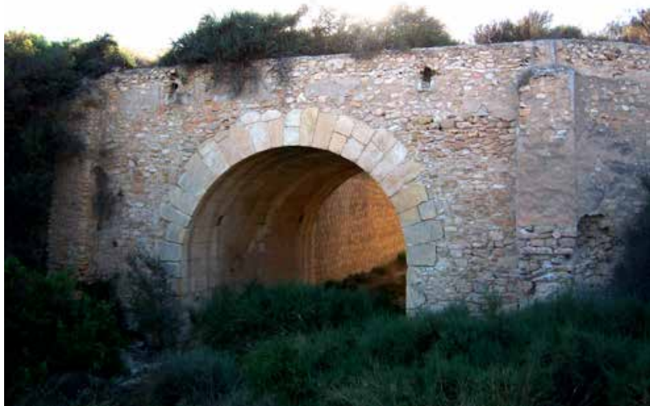
Pont sobre el barranc de Barbassena, en la carretera de la Garganta. Manuel Carreres Rodríguez, 2008.
