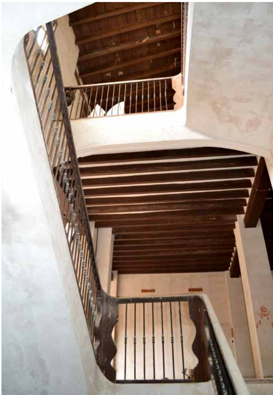
Fig. 2.- Vista de la escalera interior de la Fábrica de Augusto Mas en Crevillent (Foto: Ana Satorre)
