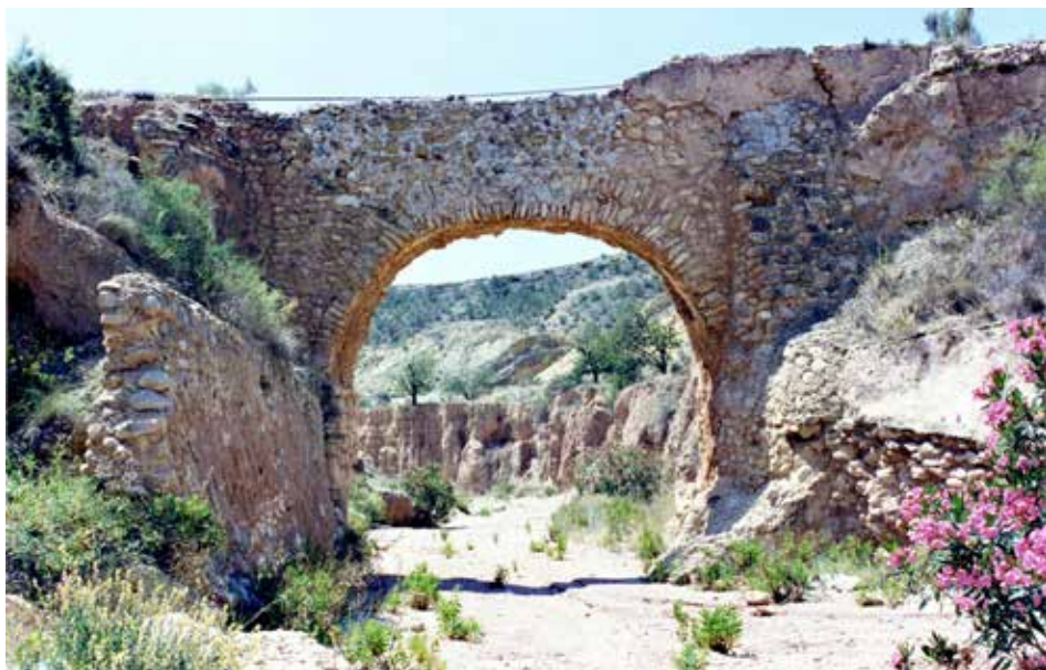
zk. Un arc de l'antic qanat de l'aigua del Poble, a la Rambla, proximitats de la tanca del Forat i la lloma del Marica.
