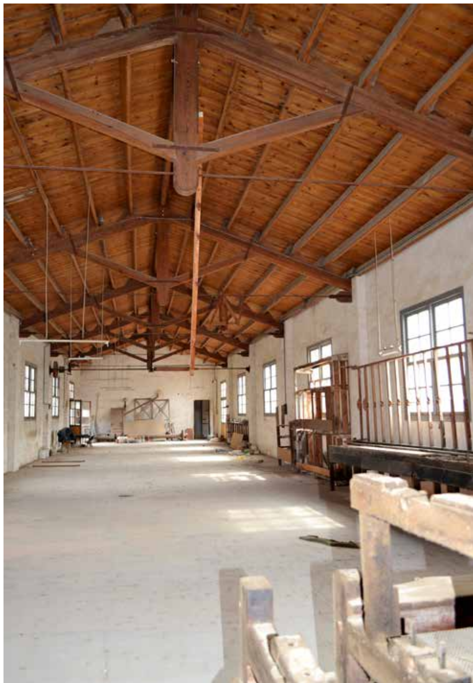
Figura 4.- Vista interior de una de las naves de la Fábrica de Augusto Mas de Crevillent con parte de la maquinaria conservada (Foto: Ana Satorre)
