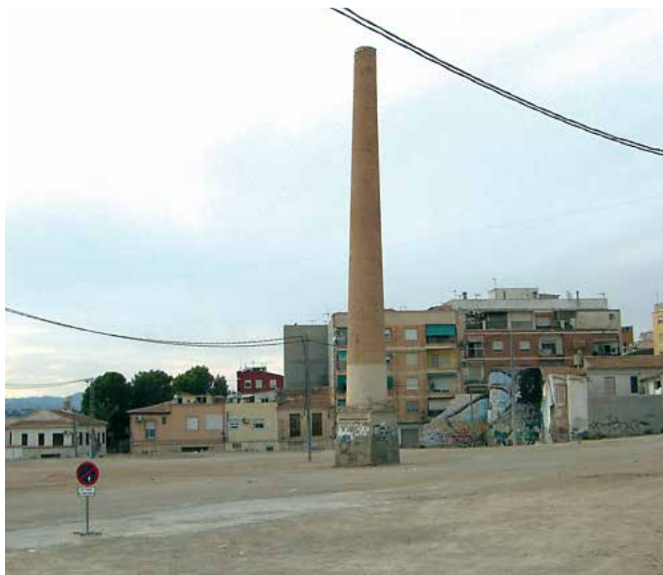
Figura 8. Chimenea Fábrica de Conservas Prieto (Barrio de San Roque-Molina de Segura)
