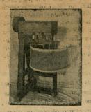
Cilindro automático sova dor para la masa del pan
