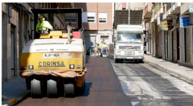
Actuaciones de reasfaltado de calles en el caso urbano
