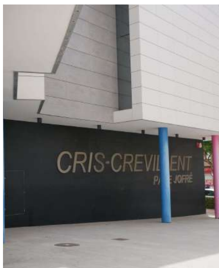
El edificio destinado al servicio del CRIS en Crevillent
