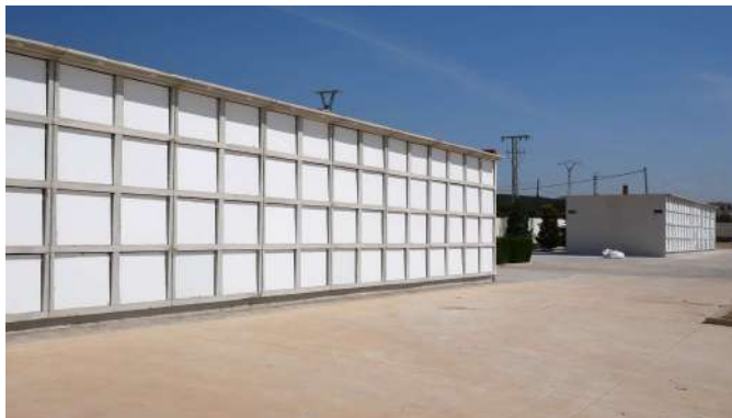
Construcción de 304 nuevos nichos en el Cementerio Municipal
