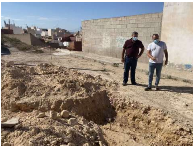
Obras de acondicionamiento de las calles Macha y Corrales
