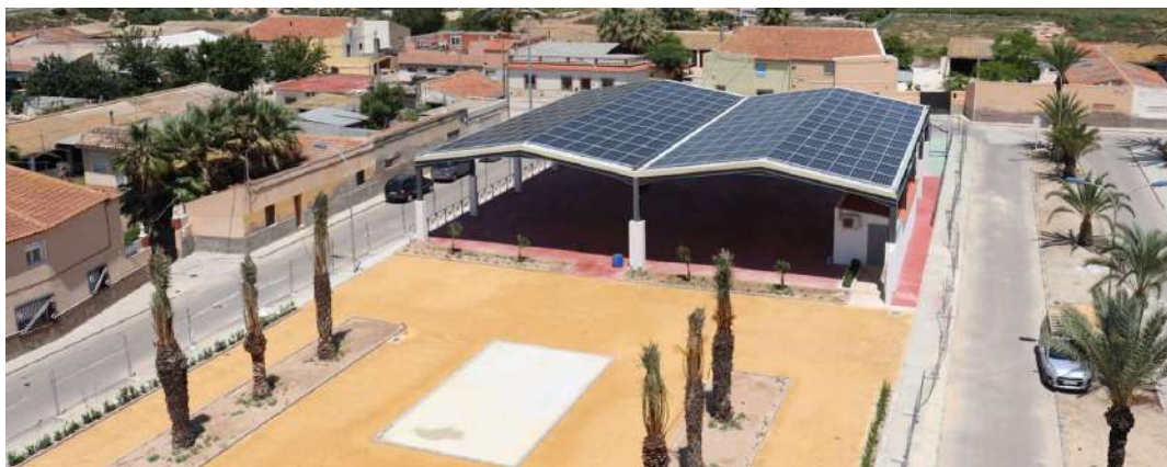
Infraestructura creada para la instalación de la célula piloto del proyecto COMPTTEM en El Realengo
