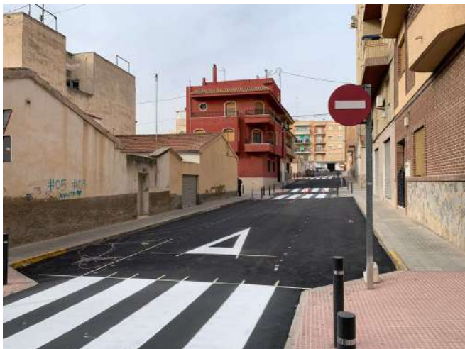
Actuaciones de reasfaltado en las vías públicas
