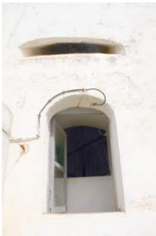
Figura 12: Torre de la Talaiola. Accés elevat amb bústia matafoc en el front de la torre.
