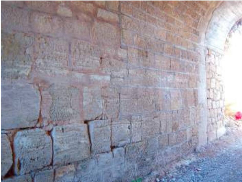
Interior del pont sobre el barranc del Catxapet on es pot observar el mur original (en primer terme) i les dues ampliacions. Manuel Carreres Rodríguez, 2014.
