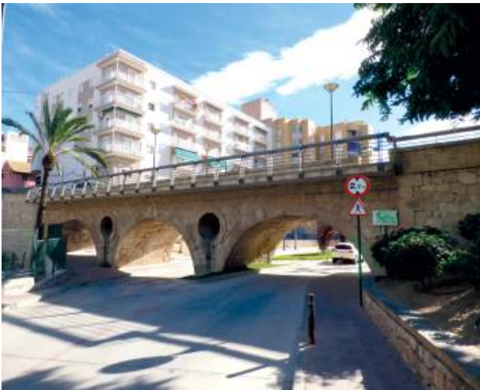
Pont de Jorge Juan. Manuel Carreres Rodríguez, 2015.
