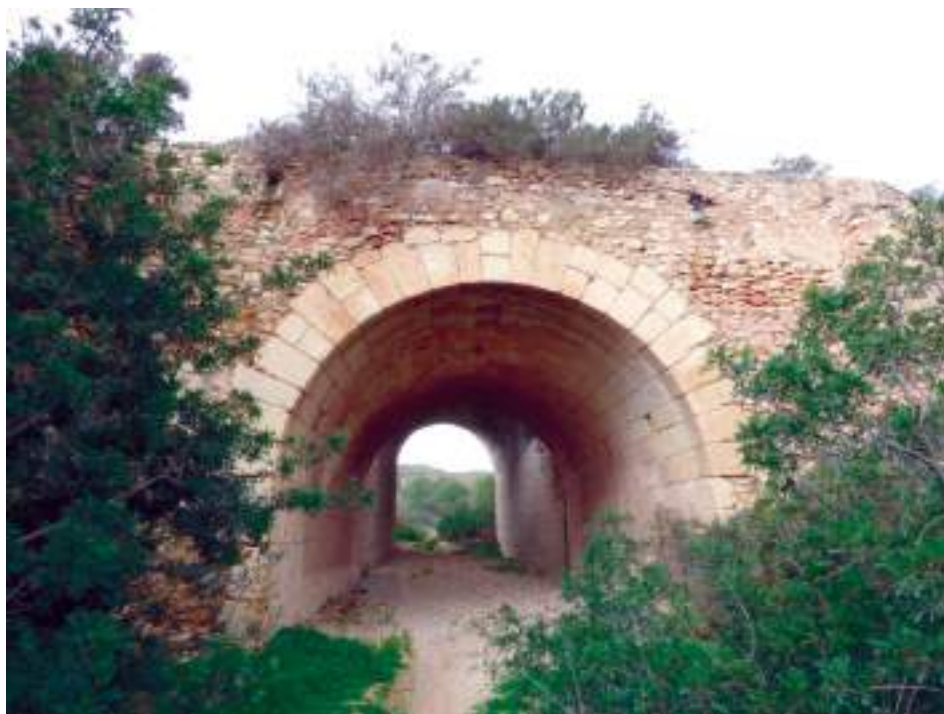
Pont de la Garganta sobre el barranc de Barbassena. Manuel Carreres Rodríguez, 2015.
