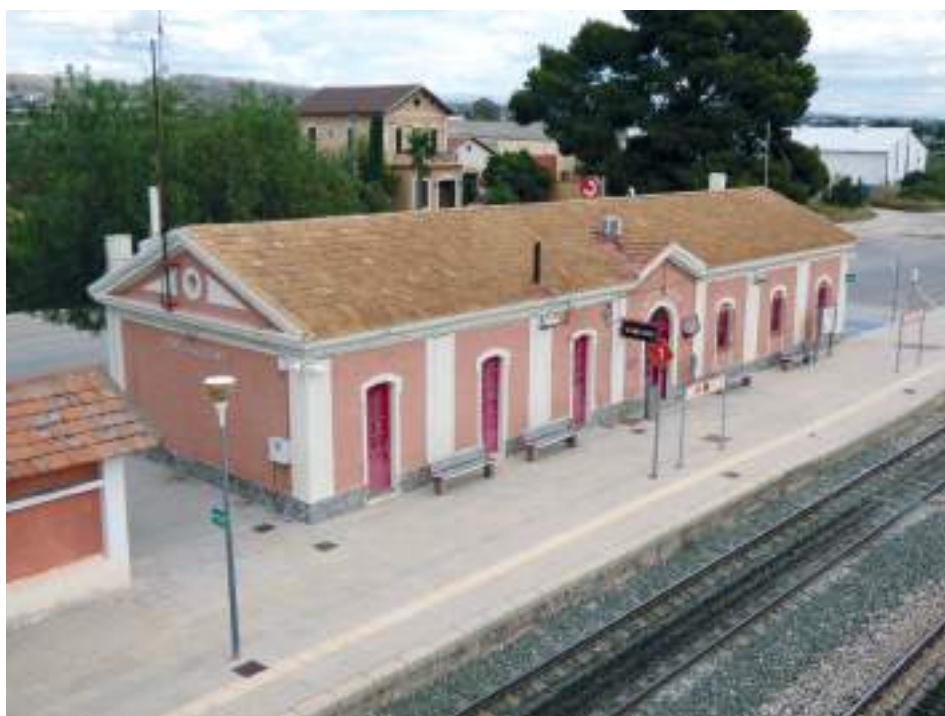
Vista general de l'edifici de viatgers de l'estació de Crevillent. Manuel Carreres Rodríguez, 2020.
