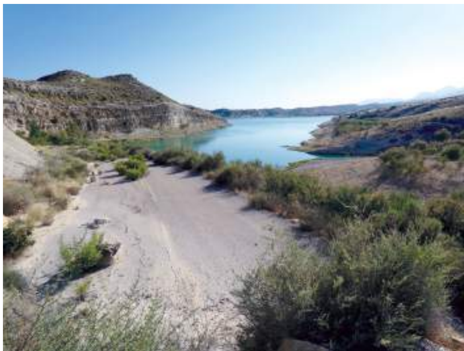
Antic traçat de la N-325. S'observa com la carretera se submergeix sota les aigües. En la paret del fons, a més, es pot veure el mur de contenció. Manuel Carreres Rodríguez, 2020.
