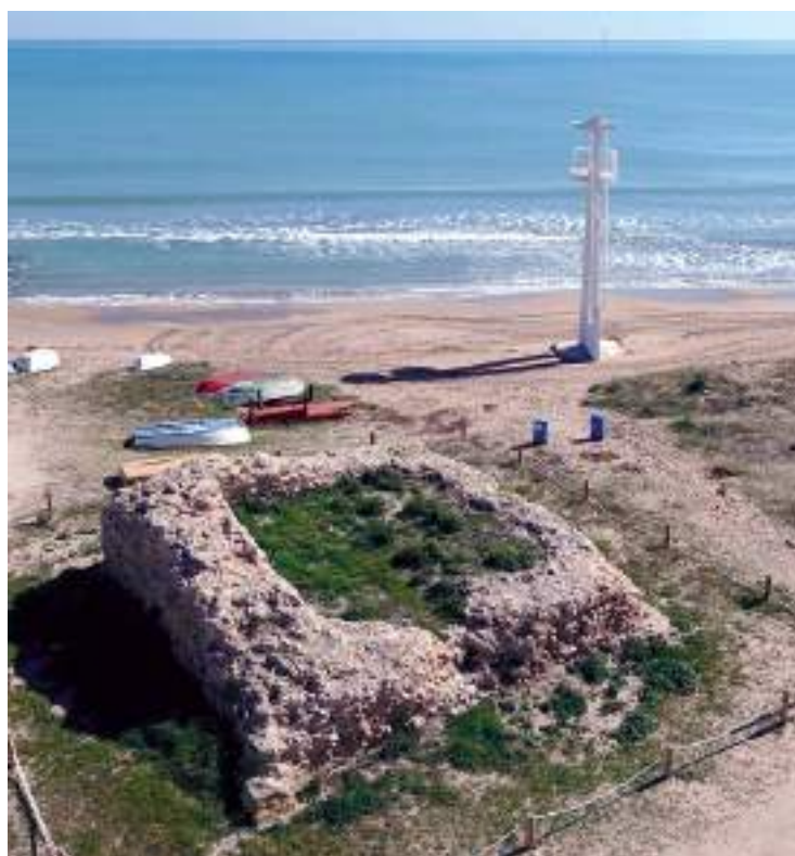
Figura 4: Vista aèria de les restes actuals de la Torre del Pinet. Foto: Projecte TOVIVA. Universitat Politècnica de València (UPV).
