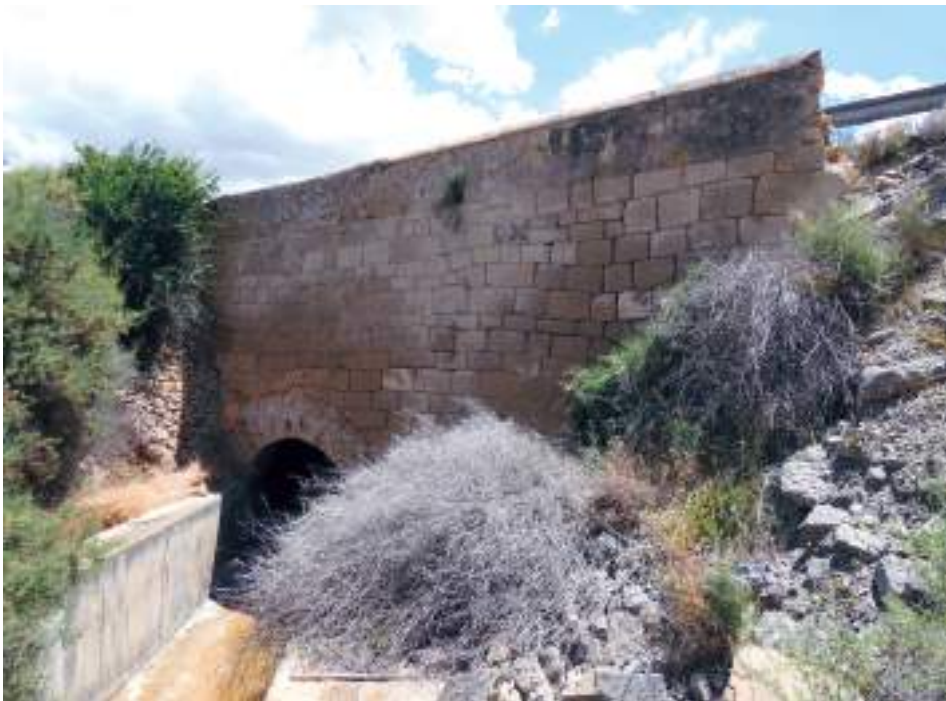
Mur de carreus, amb l'empara en la part superior i el pontó en la inferior. Manuel Carreres Rodríguez, 2020.
