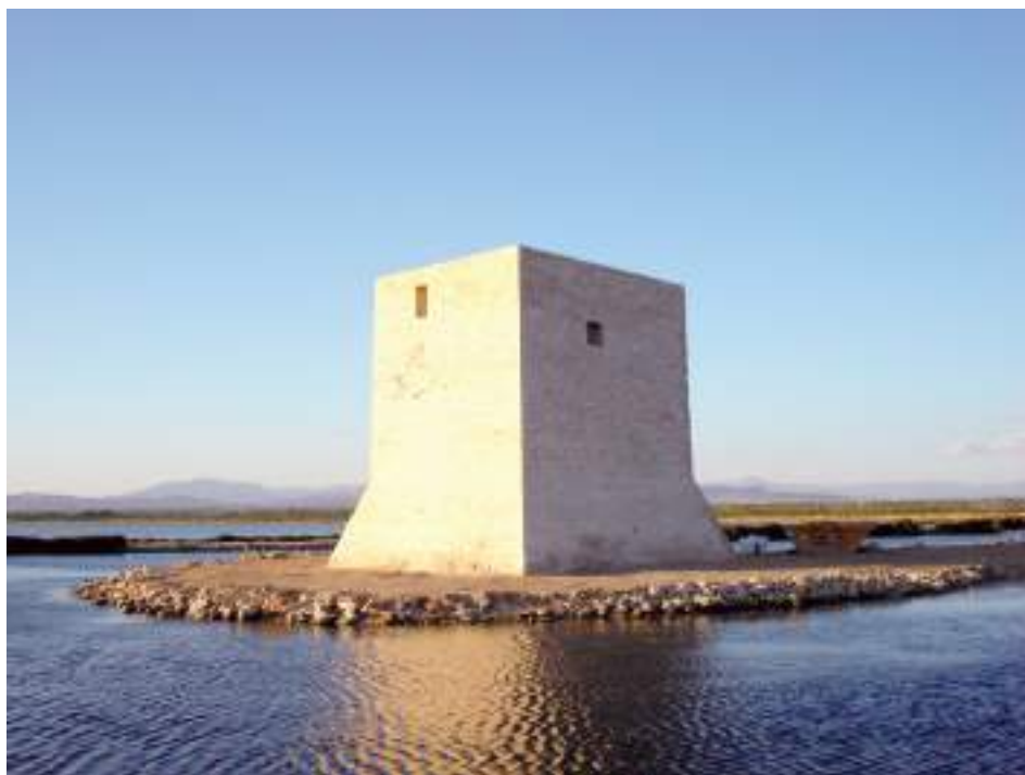
Figura 10: Vista panoràmica de l'estat actual de la Torre del Tamarit de l'Albufera d'Elx.
