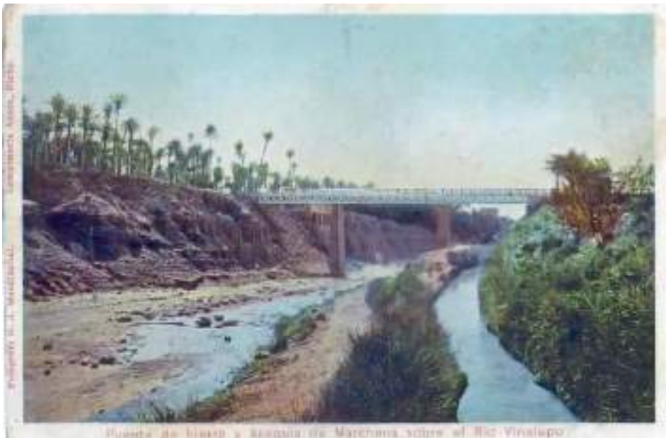
16. La Rambla d'Elx. Pont de ferro
